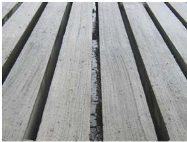
Figure 6.1 Photo de plancher de béton à lattes
