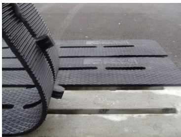
Figure 6.3 Photo de plancher de béton à lattes recouvert de caoutchouc
